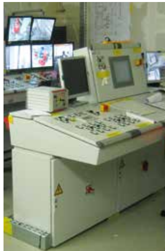
Steuerstand für den fernbedienten Rückbau
